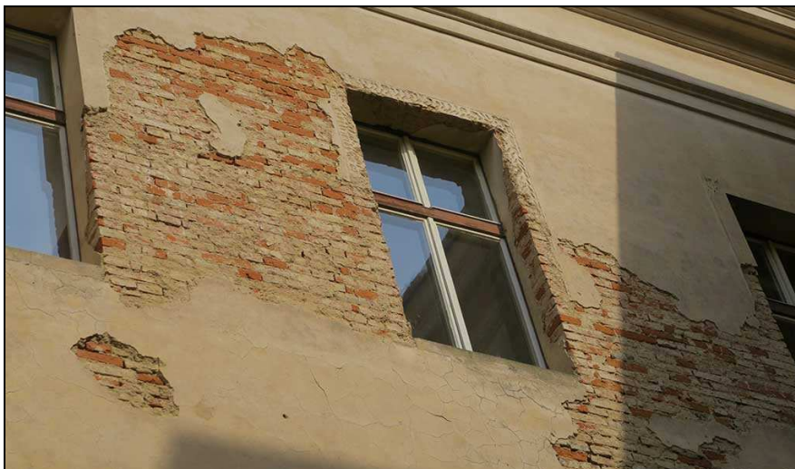
Poškozená omítka ve vnitrobloku budovy.
